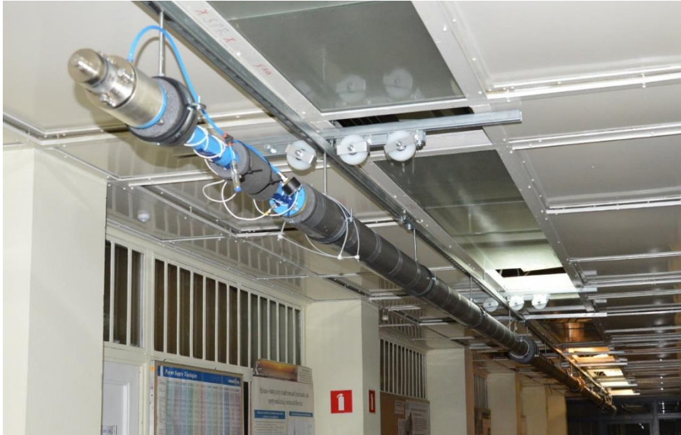
Rys. 11. Instalacja prototypowego odcinka linii PRL w korytarzu na Politechnice Warszawskiej.
